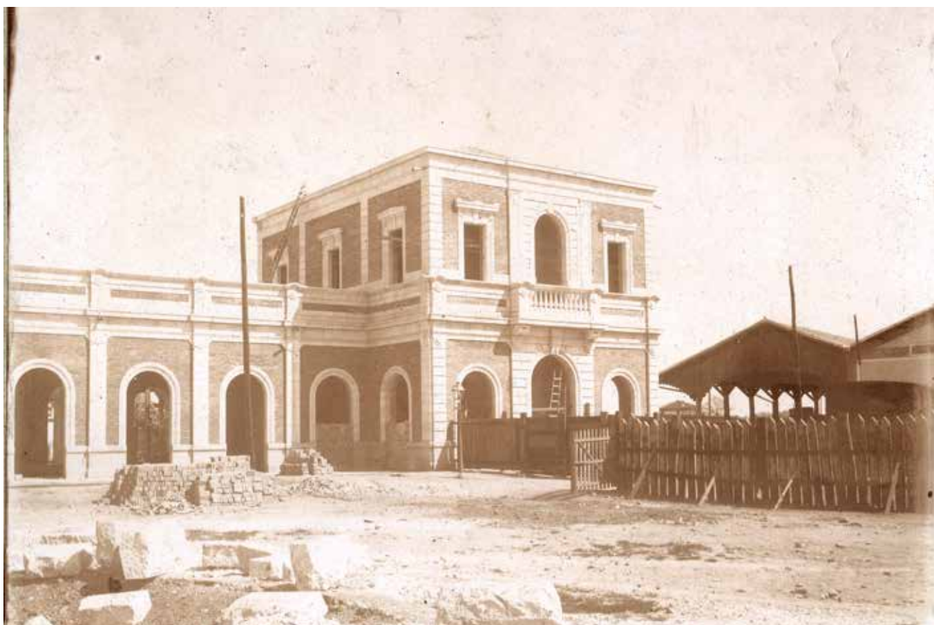
Estado de las obras en el torreón Sur de la nueva estación en 1904. Puede observarse la ubicación de la primitiva con relación a la definitiva.
